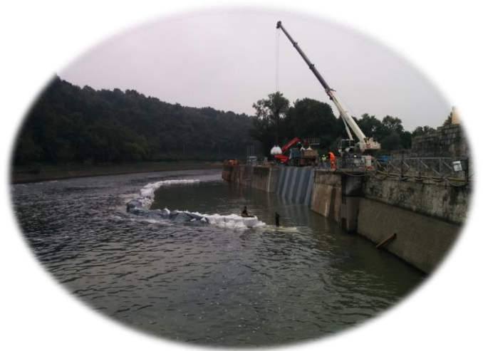
Rimozione della controttura.
