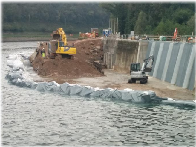
Controttura terminata e avvio della demolizione completa della tura.
