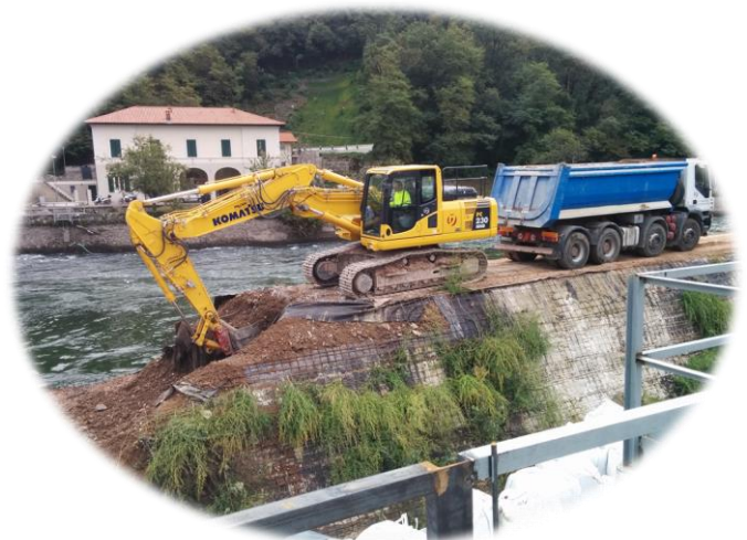
Scavo iniziale per abbassamento della tura.
