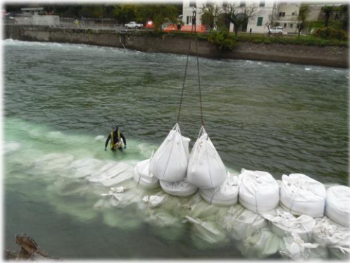
Posa dei big bag in acqua con sommozzatori.
