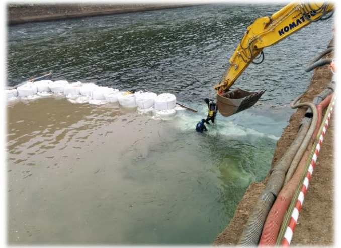
Rimozione della controttura.
