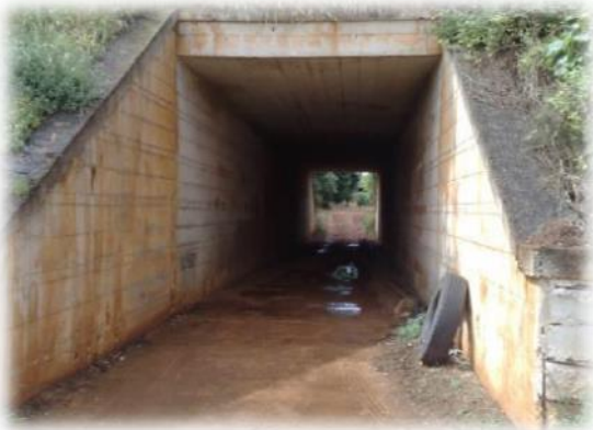
Attraversamento della SS16 Adriatica.
