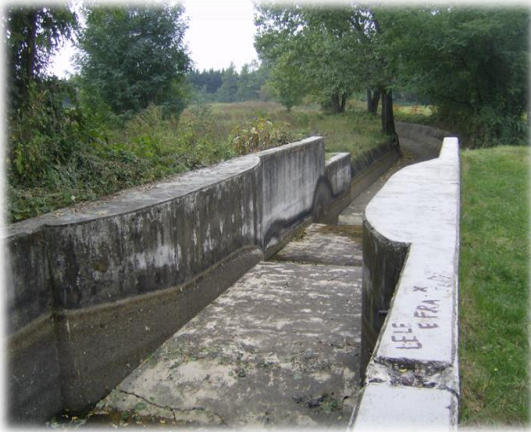
Immagine dello stato di fatto del primo tratto di canale.
