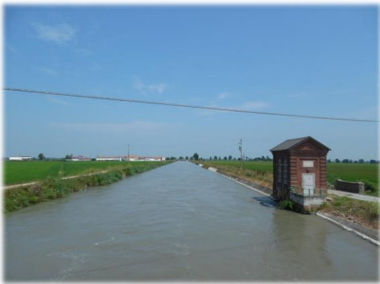
Opera di presa esistente del Cavo Lucca sul Canale Cavour.
