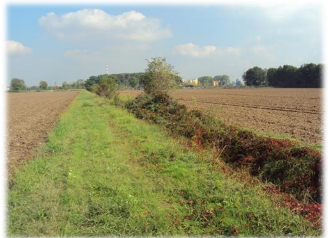
Tratto di canale da risagomare.
