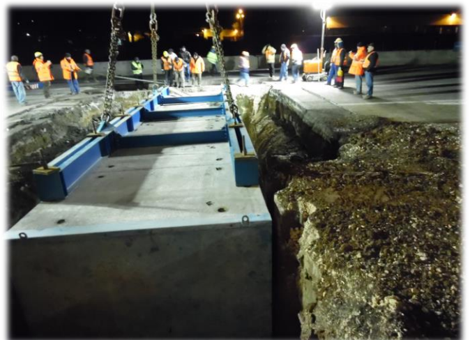
Posa del manufatto.
