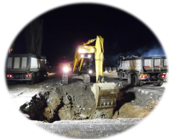
Scavo per la posa del manufatto.
