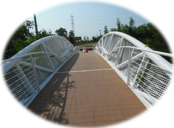
Passerella sopra il CSNO.
