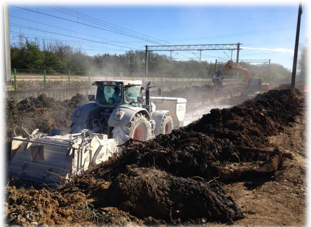
Stabilizzazione a calce del fondo del canale.
