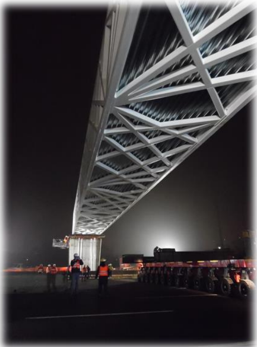
Varo della passerella sopra l'Autostrada A8.
