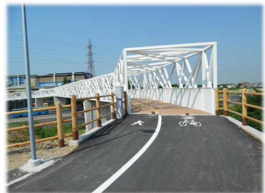
Passerella sopra l'Autostrada A8.
