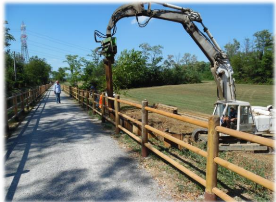
Posa di palancole nell'argine.
