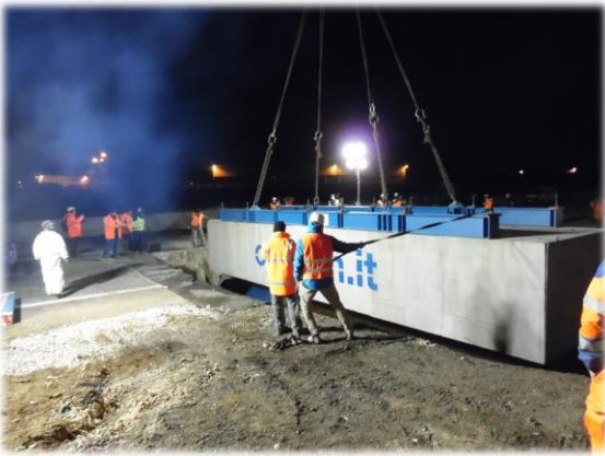
Varo del tombino sotto l'Autostrada A8 in notturna.
