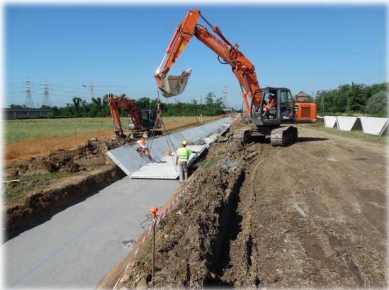
Realizzazione del canale a fianco al CSNO.
