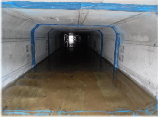
Tombino sotto l'Autostrada A8.
