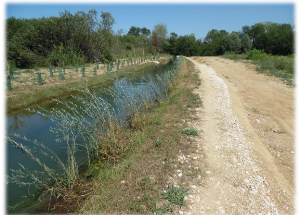
La Via d'Acqua nel Parco delle Groane.
