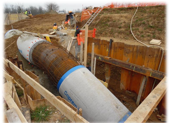
Realizzazione dello spingitubo sotto il CSNO.
