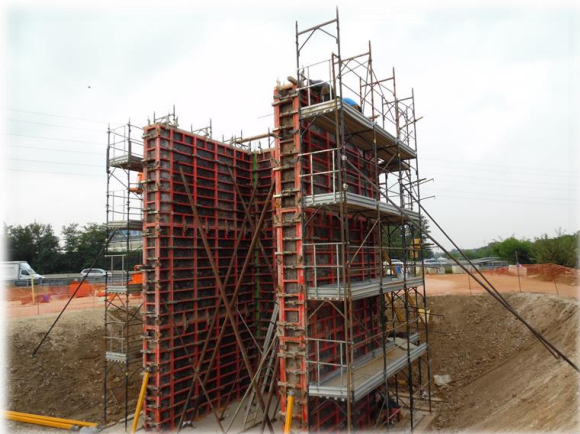
Costruzione delle pile della passerella sopra la A8.
