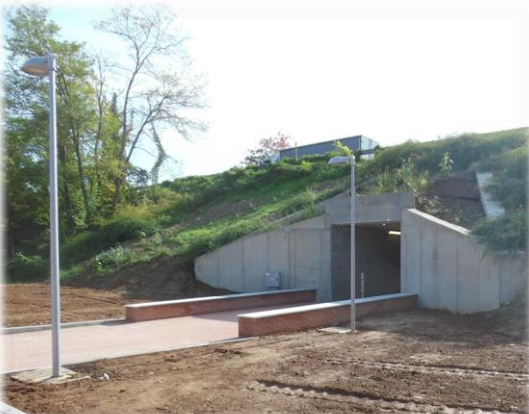
Spingitubo sotto la SP119 a lavori conclusi.
