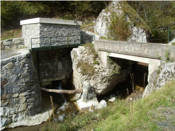
La presa e il ponte da modificare nello stato ante operam.
