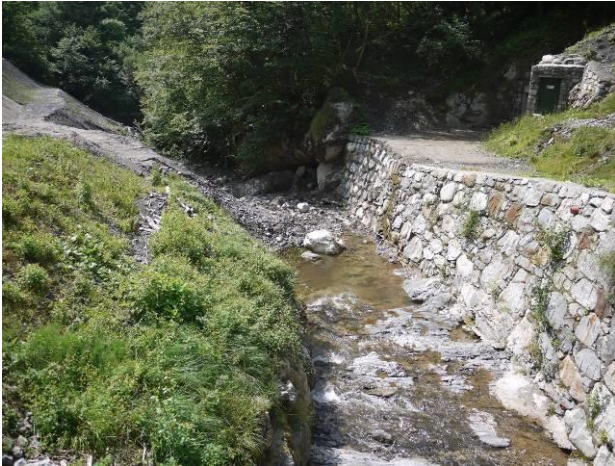
Stato di fatto appena a valle della presa.
