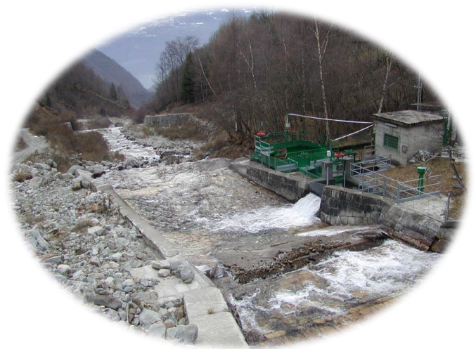
La zona presso la futura opera di presa.
