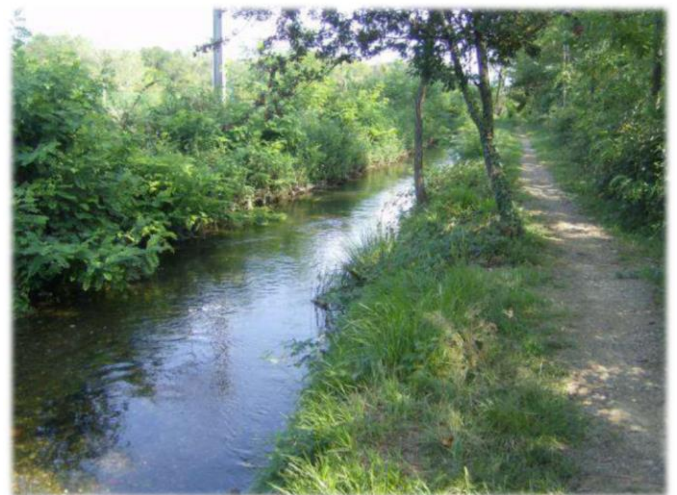
Derivatore Garbagnate esistente, oggetto di parziale ristrutturazione e "trasformazione" in Via d'Acqua
