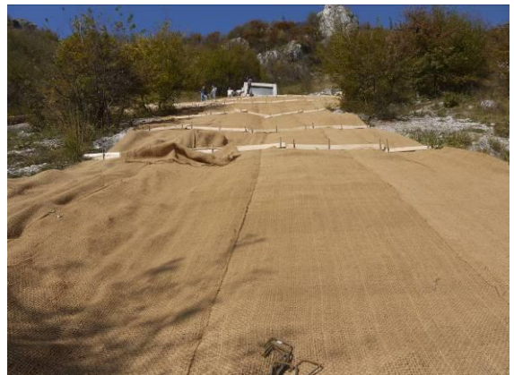
Il pendio sotto la vasca di carico durante l'intervento, con la posa di cordone vive.
