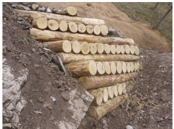
Palificata di sostegno nei pressi di un sentiero.
