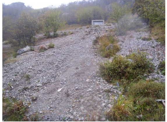
Il pendio sotto la vasca di carico prima dell'intervento.
