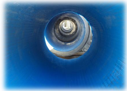
Rivestimento in liner di polietilene di alcune condotte.
