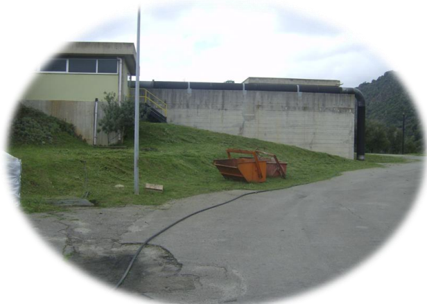
L'impianto di potabilizzazione di Bau Pressiu.
