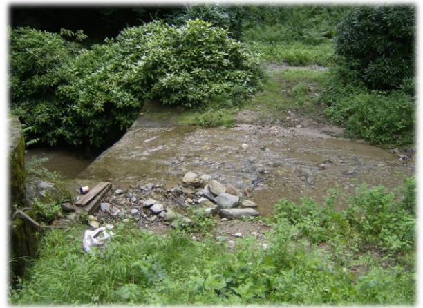
L'esistente soglia presso l'opera di presa.
