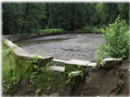
La zona dell'opera di presa e l'esistente laghetto artificiale.
