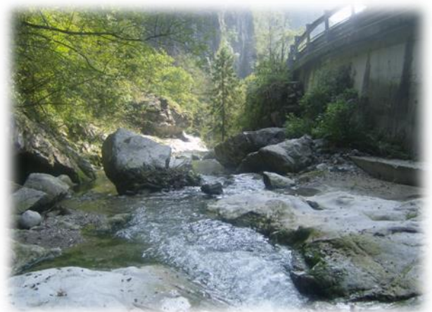
Il tratto di Torrente Serina appena a valle dell'opera di presa.
