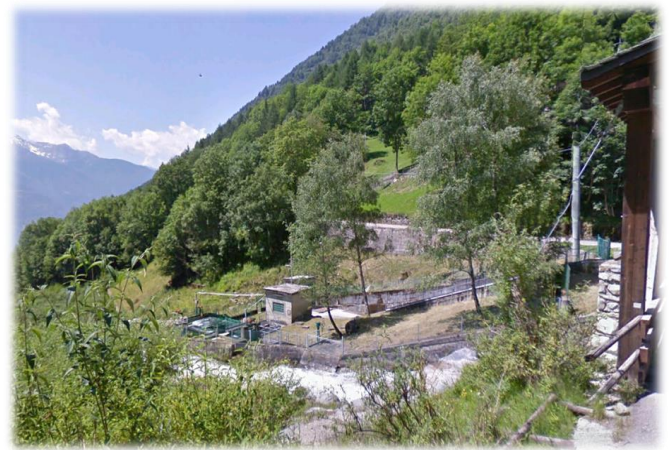
Derivazione esistente appena a valle della centrale dell'impianto sulla Val Fontana.
