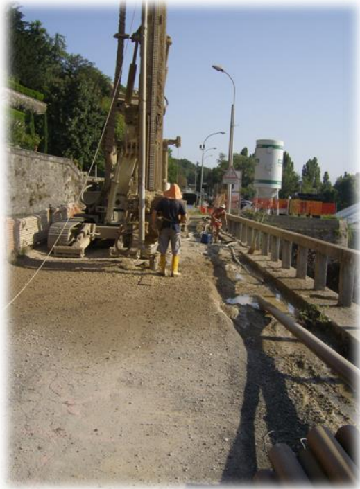
Realizzazione di micropali sulla Strada Alzaia Sud.
