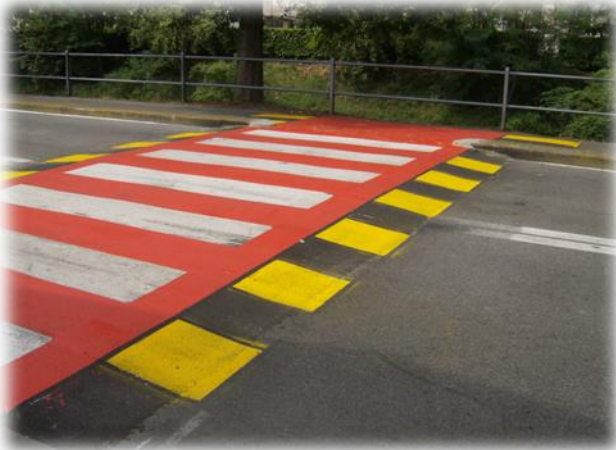
Realizzazione di dossi a Gropello.
