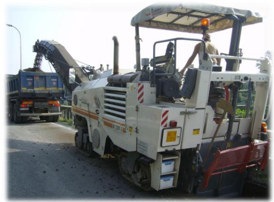
Fresatura della strada.
