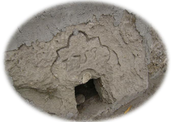
Particolare del muro restaurato.
