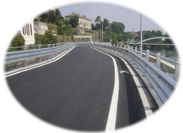
La strada e il nuovo guard-rail ad opere concluse.
