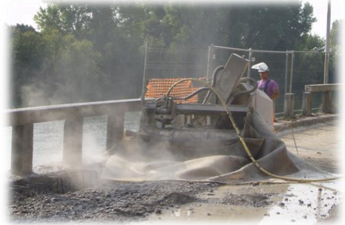
Idrodemolizione del cordolo del guardrail esistente.
