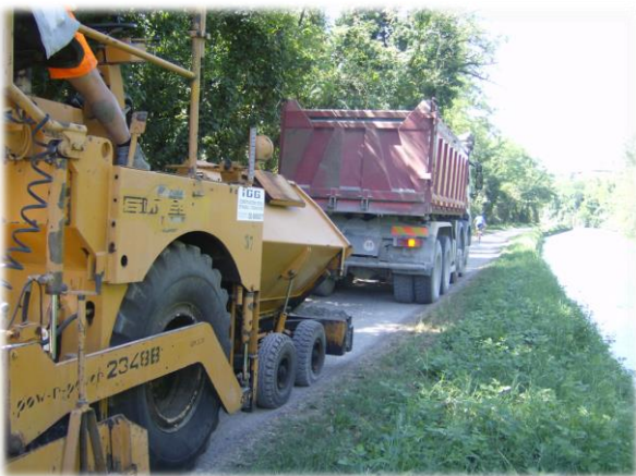
Stesa di calcestre sulla pista per Gropello.
