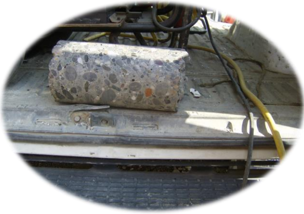
Esecuzione di carotaggi sulla struttura esistente.
