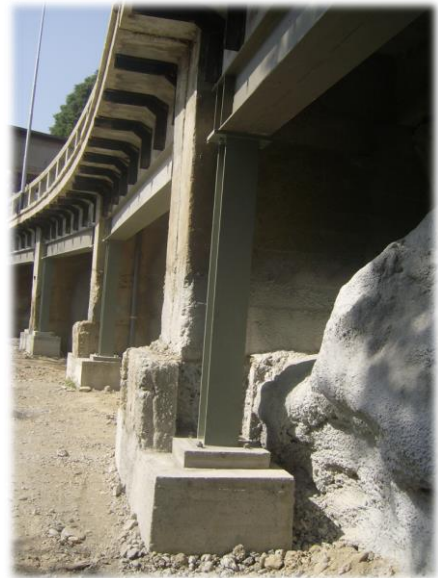
La pista di manutenzione e la carpenteria di rinforzo ad opere concluse.
