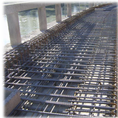
Armatura della soletta stradale.
