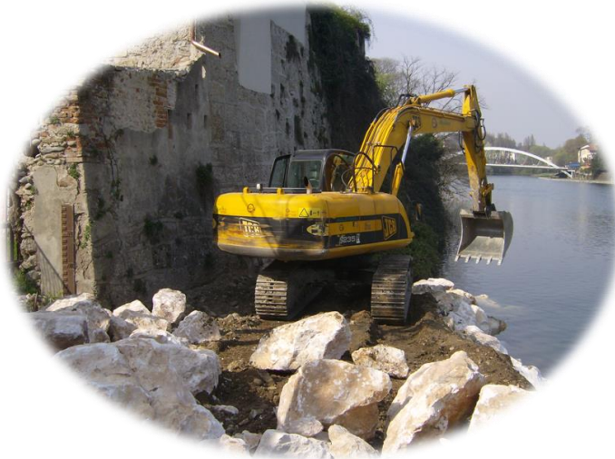
Realizzazione della scogliera nel primo tratto di pista di manutenzione.
