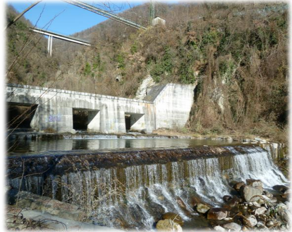
La derivazione esistente nei pressi della centrale esaminata.
