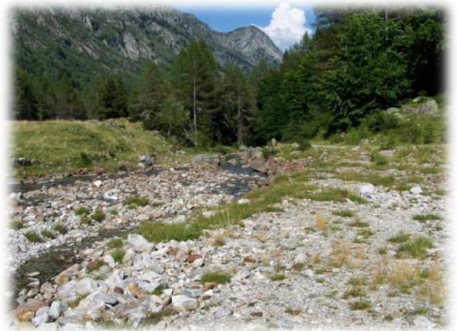
La zona dell'opera di presa.
